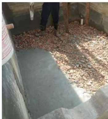
Gambar 5.3 Proses perbaikan bak pengendapan I (bak aerob)
