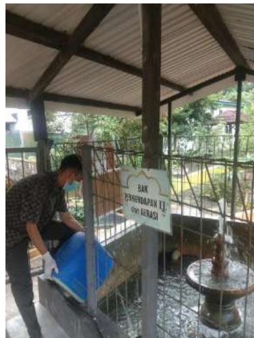
Pemberian bakteri pada bak pengendapan II / aerasi
