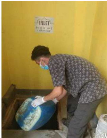
Pemberian bakteri pada bak anaerob
