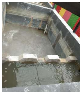
Gambar 5.3 Proses perbaikan bak pengendapan I (bak aerob)
